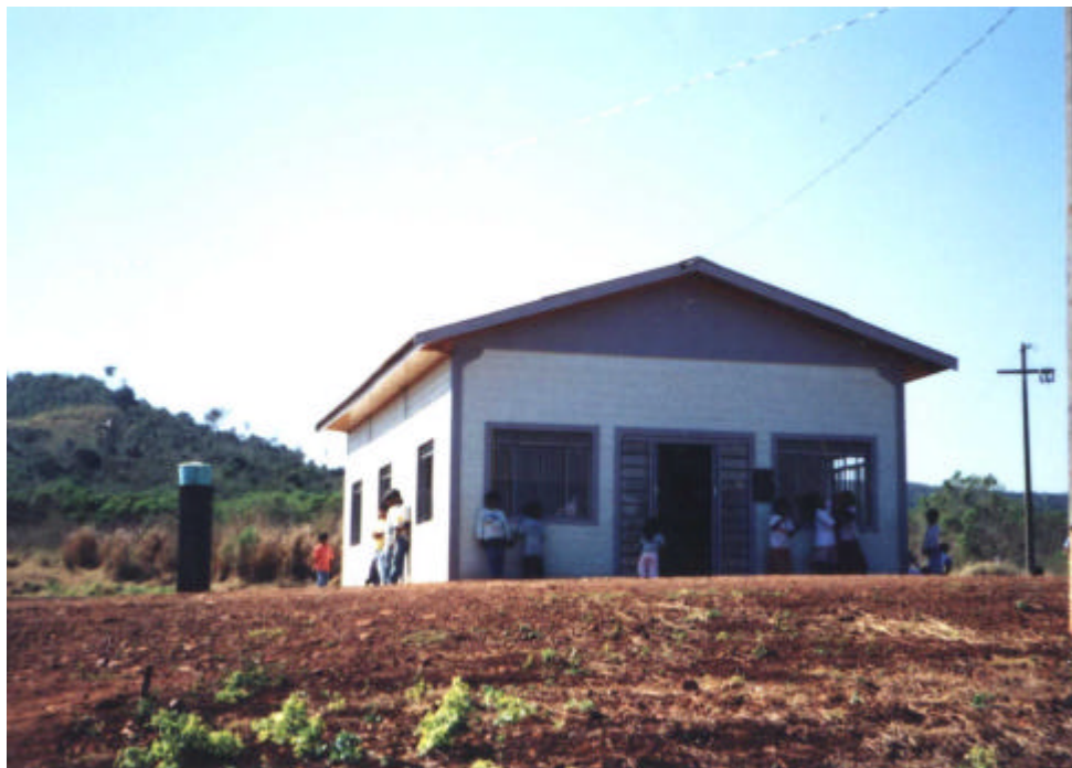
Foto12 Centro de Educação Ambiental onde funciona a escola. Foto: Zeila Costa, 2001.
