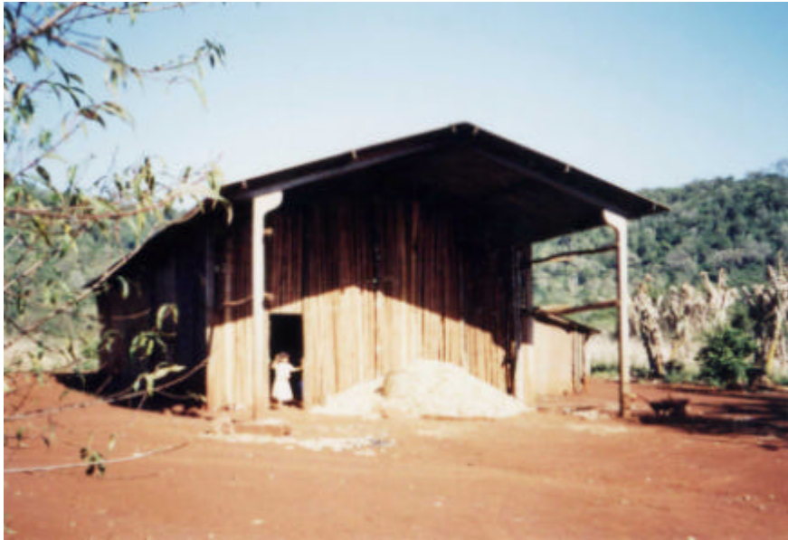
Foto 2 Moradia onde foi utilizada a estrutura de concreto e o telhado de amianto para a construção de uma nova oga Foto: Zeila Costa, 2001
